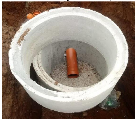
Imagem 3: Anéis de concreto armado e confecção de PV 0,8m
