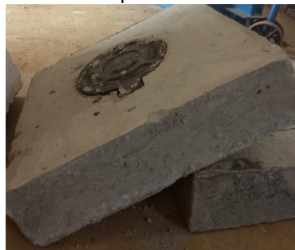
Imagem 4: Tampa FºFº em tampa de concreto para TL
