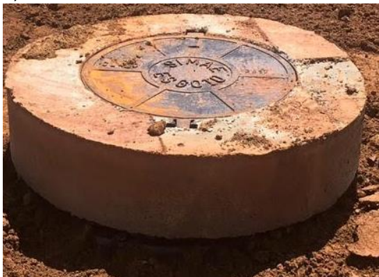
Imagem 2: Tampa do PV 0,8m com Tampão 0,6m em FºFº
