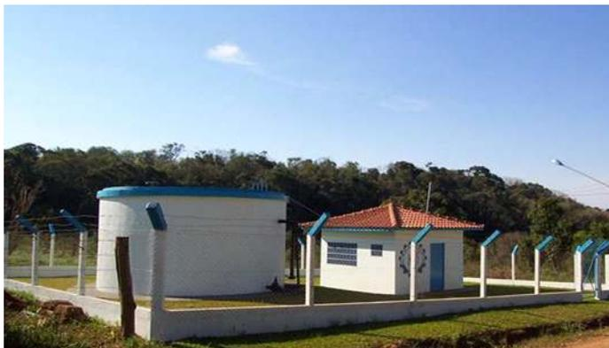
Foto da ETA – Estação de Tratamento de Água do SIMAE, composta de casa de química e reservatório na Localidade de Vidal Ramos Capinzal.
