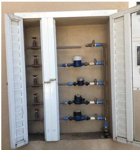
Foto do Padrão de ligação para cinco hidrômetros.
