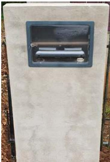
Foto do Padrão de ligação para um hidrômetro.
